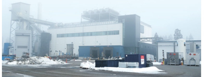
Fazerin merkittävimpiä viimeaikaisia alueellisia rakennushankkeita on ollut ksylitolitehdas.
